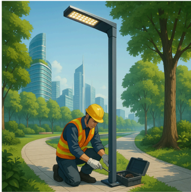
5.2 ติดตั้ง/ซ่อม ไฟฟ้าส่องสว่าง ดวง
